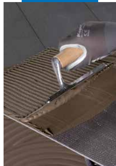
Aplicarea adezivului pe spatele placii
