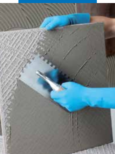
Intinderea adezivului pe spatele placii
