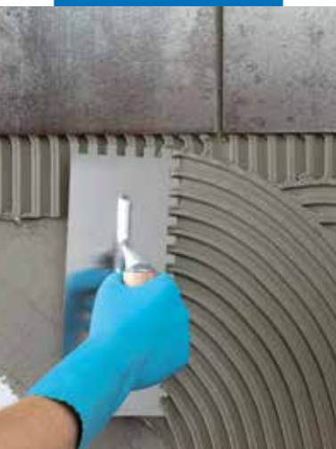
Intinderea adezivului cu spatula pe perete
