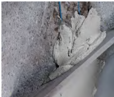
Finisarea Planitop Rasa & Ripara Zero cu un dreptar
