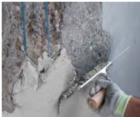
Aplicarea Planitop Rasa & Ripara Zero cu o spatula
