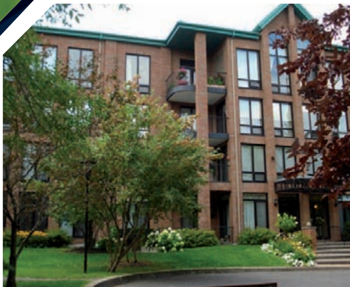
vedere din față a clădirii
