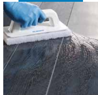
Curățarea chitului de rosturi cu un pad Scotch-Brite®
