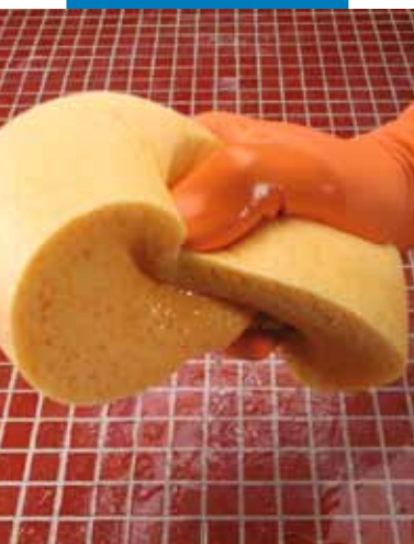
Umezirea suprafeței chituite înainte de curățare
