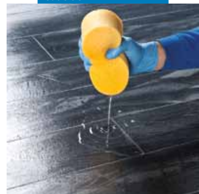
Umezirea suprafeței chituite înainte de curățare
