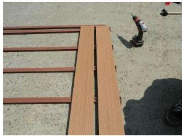
5. Cu ajutorul unui ciocan de cauciuc se impinge scandura sub clemele deja fixate, dupa care se continua cu fixarea clemelor pe cealalta margine a scandurii.
