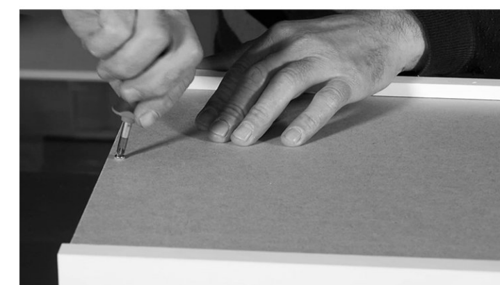
19 - Se asigura tabla spate cu holsuruburi.
