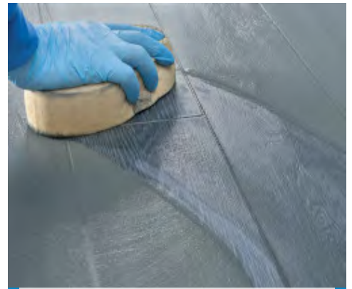
Curatarea si finisarea rosturilor cu buretele din celuloza dura
