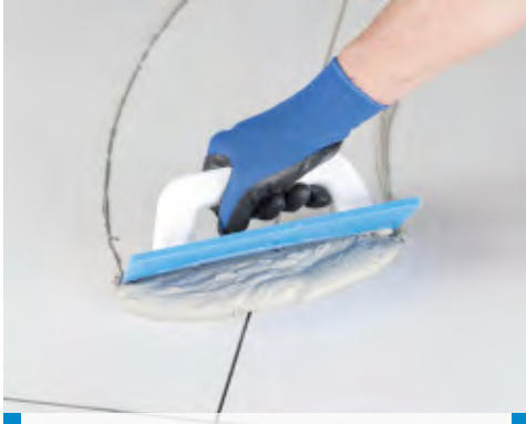
Intinderea chitului Ultracolor Plus cu spatula cauciucata pe o pardoseala din gresie portelanata
