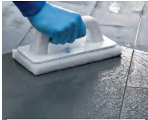
Curatarea rosturilor cu un pad abraziv Scotch Brite (cand produsul este semi-intarit)
