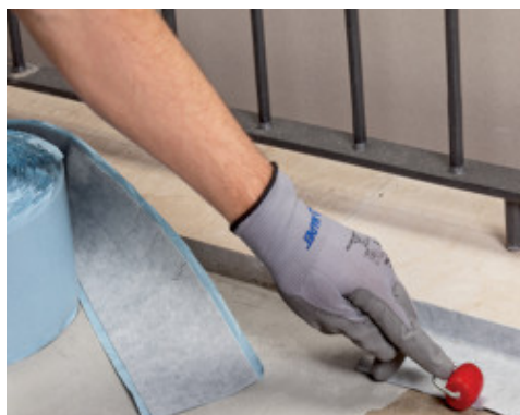
Aplicarea de Mapeband SA la imbinarea cu diferite margini ale altor materiale
