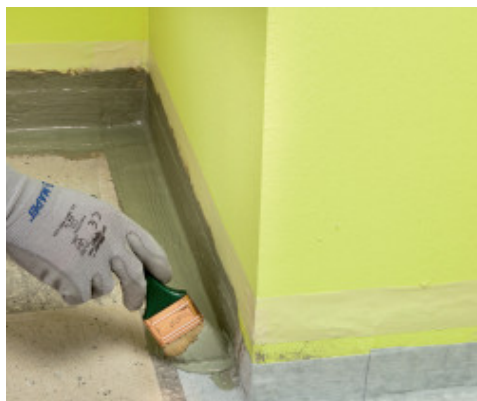
Aplicarea de Mapeband SA pe o sapa de ciment
