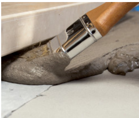
Aplicarea de Mapeband SA in locuri dificile cum ar fi pragul de usa
