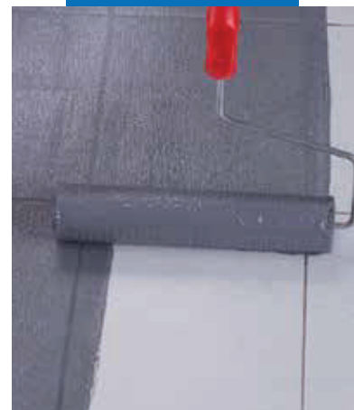
Aplicarea de Eco Prim Grip Plus pe plăci din gresie porțelanată, cu un trafalet
