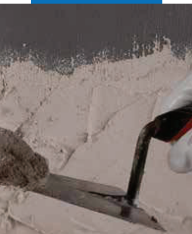
Aplicarea unei tencuieli pe Eco Prim Grip Plus
