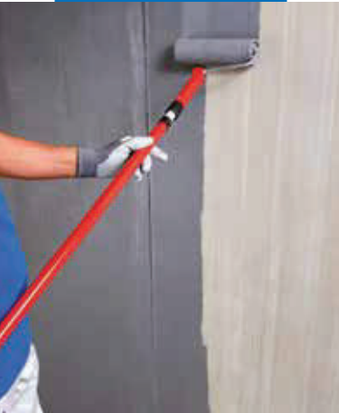
Aplicarea de Eco Prim Grip Plus pe beton, cu un trafalet
