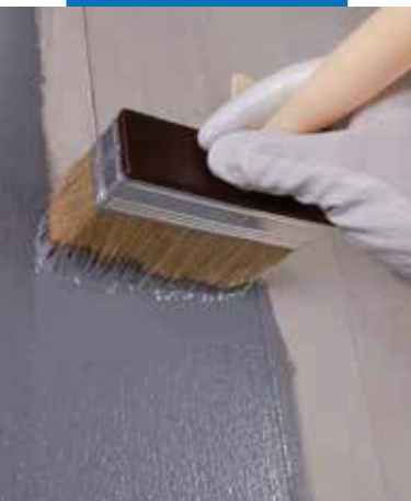
Aplicarea de Eco Prim Grip Plus pe beton, cu o pensulă
