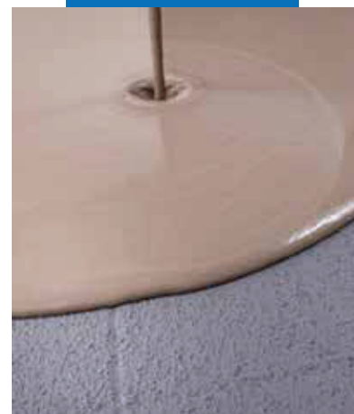
Aplicarea șapei autonivelante pe Eco Prim Grip Plus uscat, aplicat în prealabil pe pardoseala existentă
