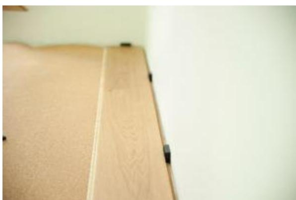
**10.** Montăm prima placă de parchet iar cu ajutorul penei de dilatare lăsăm la perete un spațiu de dilatare de minim 10 mm
