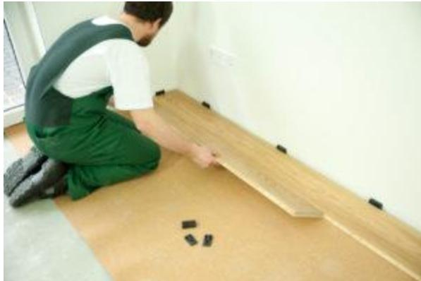
**13.** Cu placa de parchet tăiată începem montajul celui de-al doilea rând de parchet. Introducem placa în click la un unghi de aprox.  $20^{\circ}$ - $30^{\circ}$
