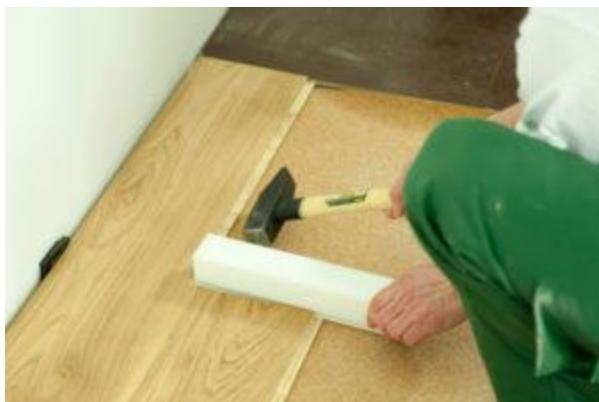
**11.** Urmatoarea placă o montăm cu muchia scurtă pe partea frontală a primei plăci și cu ajutorul unui bloc de batere le îmbinăm într-un singur rând
