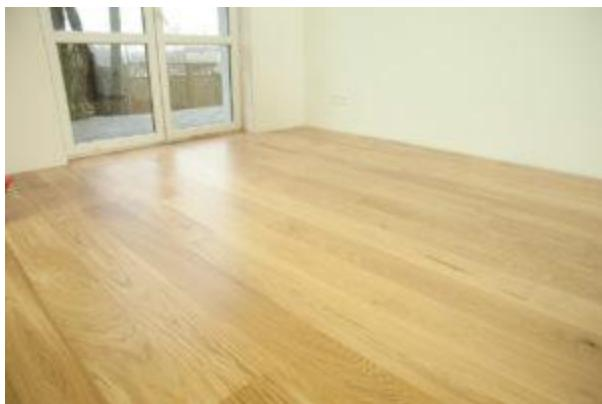
**6.** Direcția de montaj a plăcilor de parchet depinde de dimensiunile încăperii și direcția de cădere a razelor solare. Dacă nici unul dintre peretei camerei nu depășește 8m, vă recomandăm montajul parchetului în direcția de cădere a razelor solare, adică perpendicular pe cea mai mare fereastră din încăpere. În cazul unor dimensiuni mai mari de 8 m sau a încăperilor înguste și lungi, de ex. coridoare, lamelele trebuie montate întotdeauna de-a lungul celei mai lungi laturi
