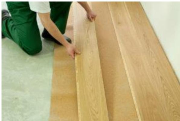
**8.** Nu uitați că parchetul stratificat este executat din lemn 100% și fiecare placă are un aspect unic. Înainte de montajul parchetului trebuie să plasați plăcile pe podea și să planificați modelul. După efectuarea acestei acțiuni puteți începe montajul.
