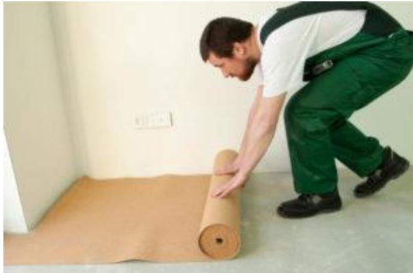
**5.**După curatarea șapei trebuie montat stratul izolator pe care vom monta parchetul, de ex. plută naturală. Nu uitați să lăsați un spațiu de dilatare între perete și plută de aprox. 10 mm. Între rolele de plută trebuie să lăsăm spatii de 2-3mm. Procedăm în mod similar cu alte materiale izolatoare, de ex. plăcile comprimate din fibre naturale de lemn .
