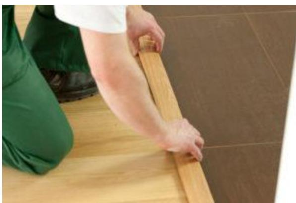
**18.** Spațiul de dilatare dintre plăcile ceramice și parchetul din lemn precum și pragul ușii trebuie mascat cu un profil de dilatare. În timpul montajului parchetului trebuie să lăsăm obligatoriu un spațiu de dilatare între cadrul ușii și parchet.
