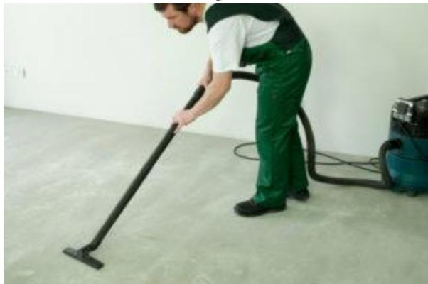
**2. .** Parchetul stratificat din lemn poate fi montat pe orice substrat drept și uscat. Înainte de montaj substratul trebuie curățat, iar denivelările nivestate cu o spatulă.
