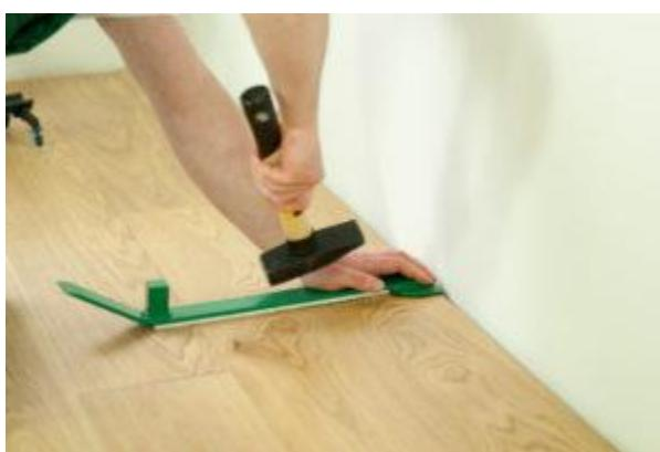
**17.** Placa de parchet o fixăm cu ajutorul dispozitivului de montaj.
