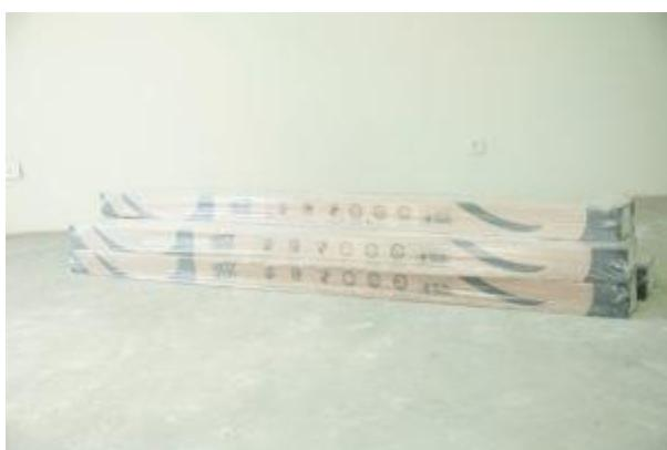
**4. Nu uitați să aclimatizați parchetul stratificat la locul montajului în ambalajul din fabrică timp de minim 48 de ore înainte de montarea acestuia. În această perioadă parchetul se va adapta la condițiile în care va fi montat și utilizat.**
