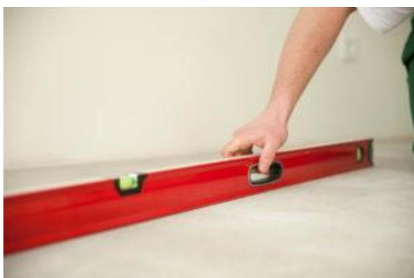
**3. Înainte de montajul pardoselii trebuie să verificați denivelările substratului.** Acestea nu trebuie să depășească 2mm pe o lungime de 1m.
