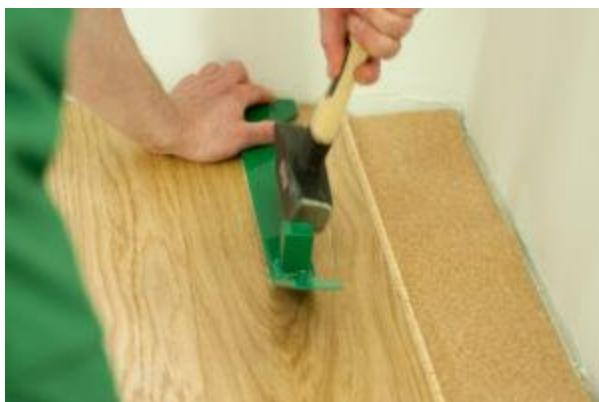
**12.** Ultima placă de parchet din primul rând trebuie tăiată în aşa fel încât ,după montajul acesteia, să rămână un spațiu de dilatare la perete de 10mm. Placa de parchet tăiată o plasăm cu îmbinarea frontală pe placă de parchet anterioară și o fixăm cu ajutorul unui dispozitiv de montaj.
