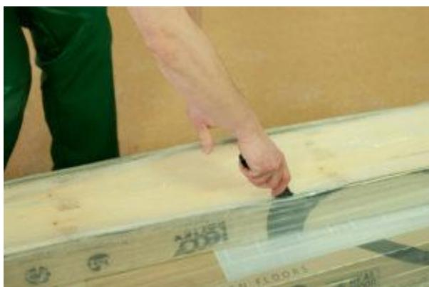
**7.** Ambalajele pachetelor de parchet trebuie tăiate cu un cuțit în partea inferioară, astfel încât să nu se deterioreze stratul superior al plăcilor.
