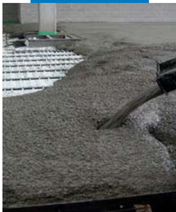
Turnarea betonului aditivat cu Mapefibre NS12 pentru evitarea contractiilor plastice
