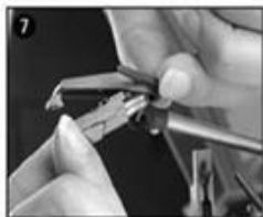
5 introduceți linia audio în mod corespunzător și instalați ușor doza în mufă.
