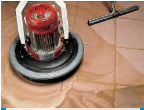
Curatarea si finisarea placilor de gresie portelanata utilizand o masina electrica cu disc din pasla abraziva si racleta de cauciuc
