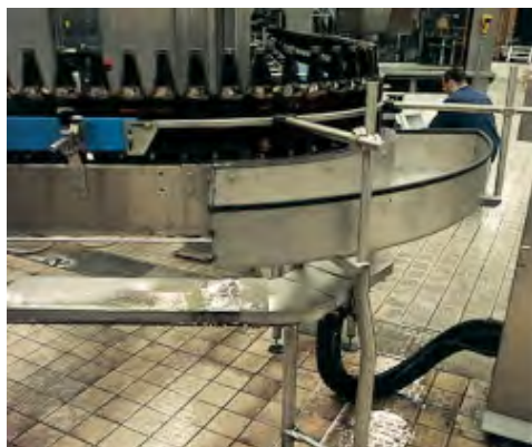
Exemplu de chituire a rosturilor pardoselii dintr-o fabrica de bere
