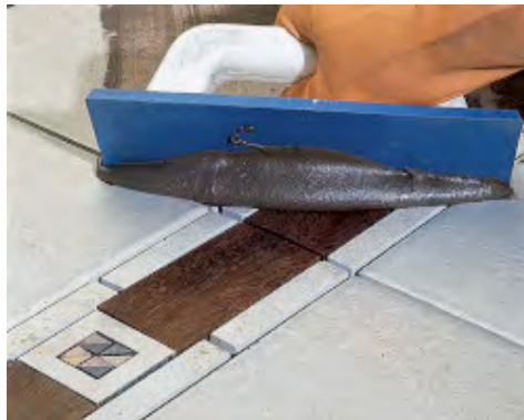
Chituirea placilor ceramice cu insertii din lemn, folosind spatula cauciucata Mapei
