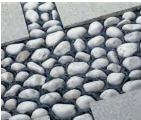
Exemplu de lipire si chituire pentru placaj cu pietre ornamentale
