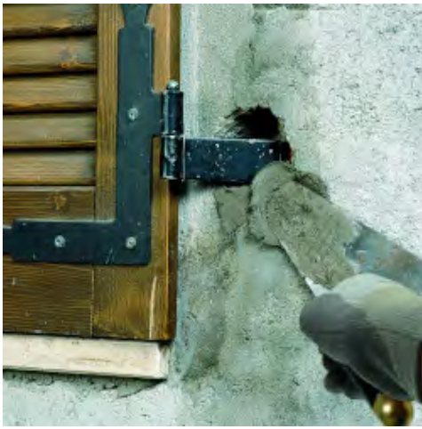
Fixarea consolelor pentru ferestre utilizand Lampocem
