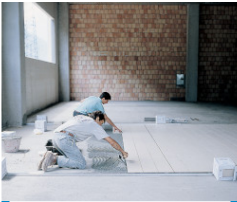
Montare de gresie portelanată la pardoseala industrială
