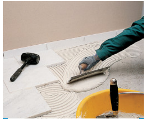
Montare marmura alba Carrara cu Granirapid alb
