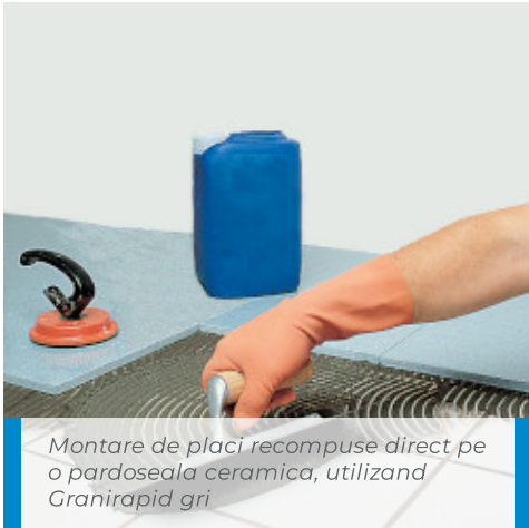
Montare de gresie portelanată la pardoseala industrială
