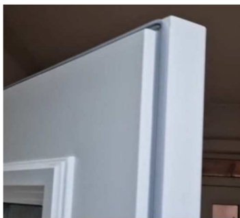
Garnitura aplicata perimetral continuu pe foaia de usa
