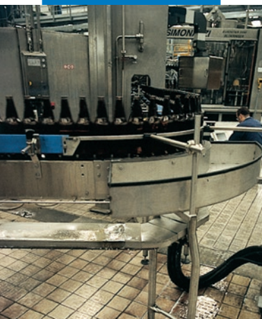
Exemplu de chituire a rosturilor pardoselii dintr-o fabrică de bere
