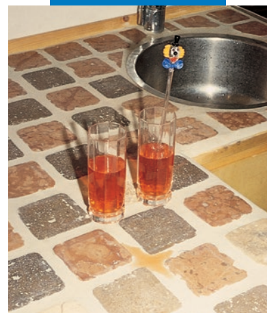
Exemplu de lipire și chitire a unui blat de lucru în bucătărie
