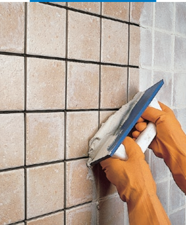
Aplicarea chitului de rosturi pe un perete placat cu gresie folosind spatula cauciucată Mapei
